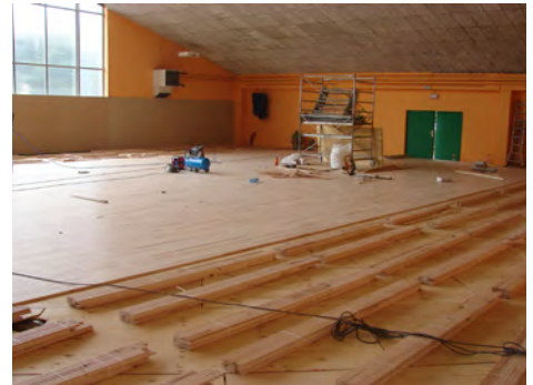
Prenova teniške in športne dvorane, 2008.
